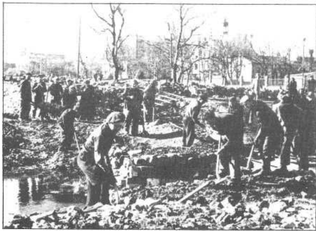
Travaux de déblaiement devant l'ancienne mairie d'Argenteuil après un bombardement.
