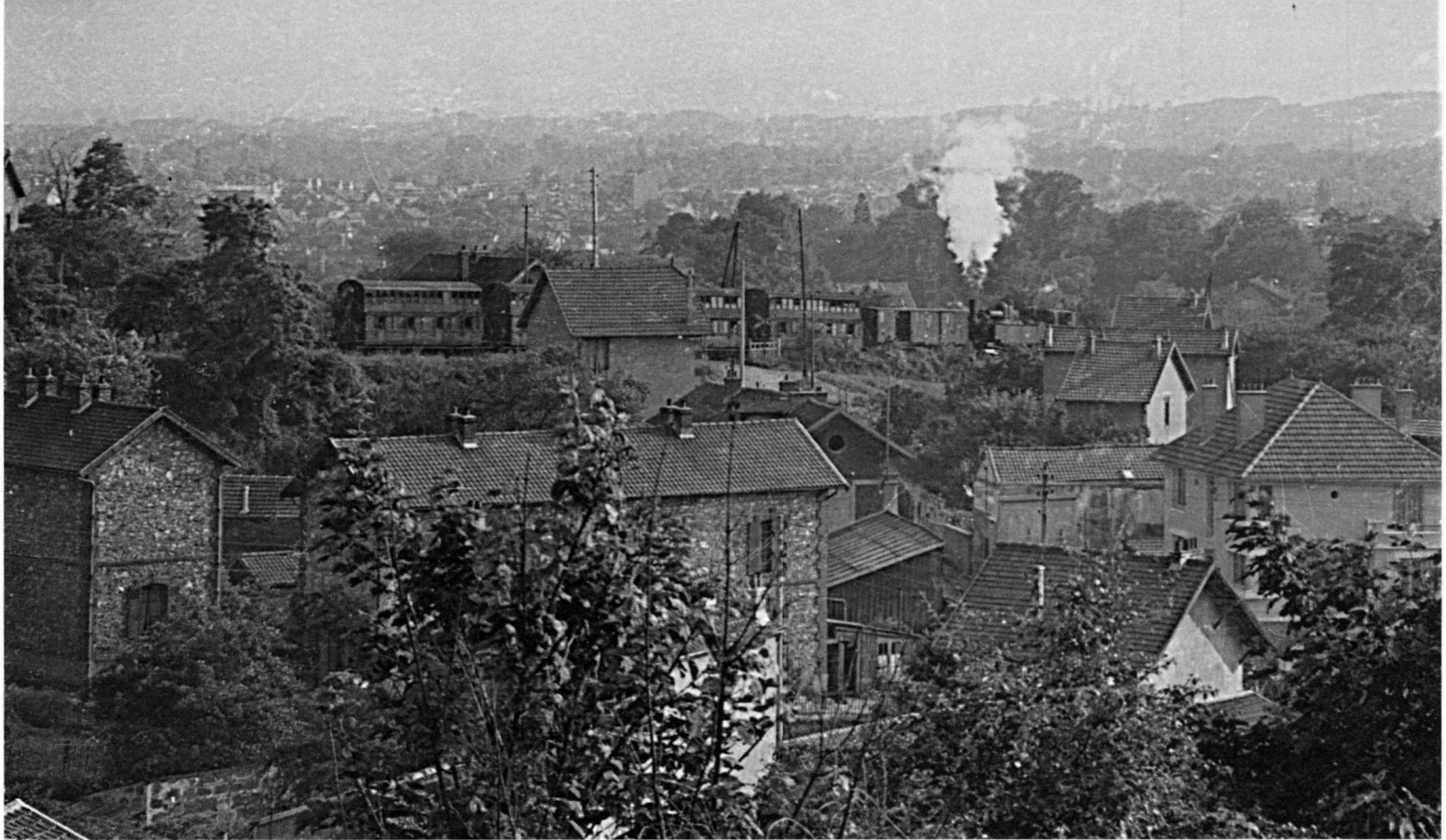
Construits de 1909 à 1911, les deux pavillons ouvriers forment un angle droit le long de la rue de Margency. A l'arrière-plan, le Refoulons franchit le passage à niveau de la rue de Pontoise dont on aperçoit la toiture de la maison de garde-barrière.
