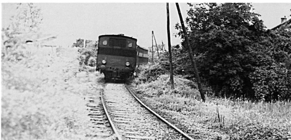
Le PN 3 du Grand Chat vu vers Enghien. La voie ferrée débouchait de l'extrême-gauche, à l'emplacement de la voiture puis, une fois franchi le PN, dont on voit la maison de garde-barrière, elle longeait sur la droite la rue des Moléons. Sur l'ancienne emprise, la ville de Soisy a établi un entrepôt (photo du haut). Du passage à niveau du Grand Chat au passage à niveau de la rue de Pontoise, l'emprise a été affectée à la circulation pédestre. A droite du cliché, les premières habitations de l'ancienne carrière Marchand bordent la voie ; à gauche, cachée par une haie vive, la rue des Saules suit le même trajet que le chemin de fer (photo du bas).
