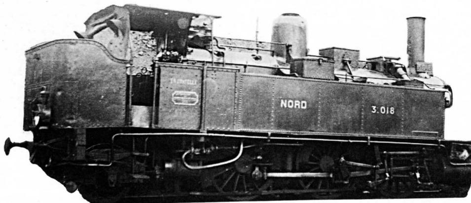
*Dérivée de la 030 T, la 031 T série 3011/3020 a été dotée d'un bissel arrière et d'une plate-forme de stockage de charbon. Les caisses à eau, de part et d'autre du corps de chauffe, se prolongent jusqu'à la boîte à fumée. Ici, la 3.018, photographiée après 1918 (l'indication du dépôt d'attache date de la Grande Guerre).*
