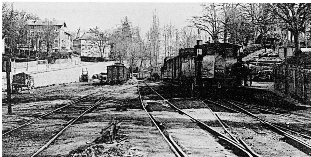
Jusqu'à ce jour, aucune photographie du plan incliné et de son terminus en gare de Montmorency n'a pu être retrouvée. De ces installations disparues dès 1880, il ne reste plus que le trou béant au fond de la gare et une place vide dans la cour des débords, le long de la voie de service. Au fond à gauche, un quai au vin sera édifié en 1884.
