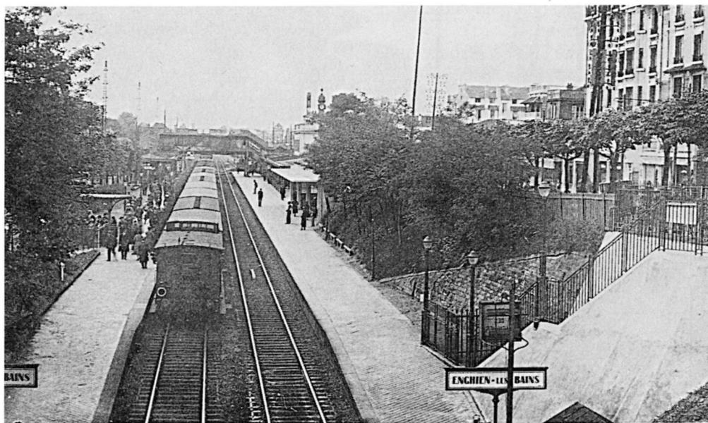
*Après les travaux ferroviaires, une rampe sur le quai de l'arrivée et un escalier sur le quai du départ permettent d'accéder ou de sortir de la gare vers la place Foch. Un abri supplémentaire a été construit sur le quai de départ.*
