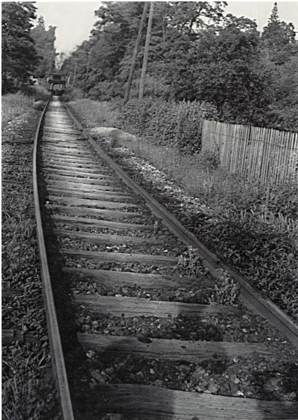
du rapport précise que certaines traverses sont à remplacer par suite de rupture, conséquence directe du sabotage susmentionné, mais que d'autres le sont par suite du mauvais état du bois, notamment au passage à niveau 2 (la Pointe-Raquet). Sur les deux cents traverses à changer, quatre-vingts doivent l'être immédiatement, les autres pourront ne subir qu'un entretien : recoupe d'épaulement, bouchage des boulons, reperçage, etc.
