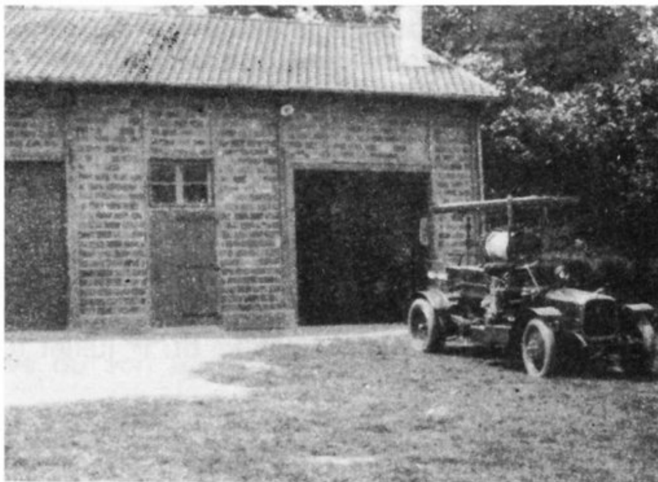
La remise de la place Gambetta.
