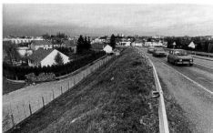
L'autopont de la RD 124.
