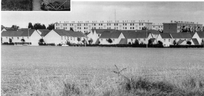
Pavillons locatifs aux Coquelicots devant les immeubles des Longues-Raies.
