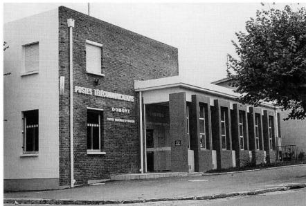
Le bureau de poste actuel, avenue Jean-Jaurès.
