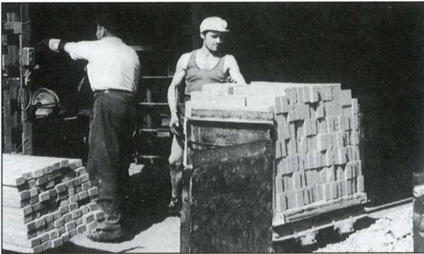
10 - Les briques sont retirées du séchoir à air chaud pour être transportées au four par wagonnets.
